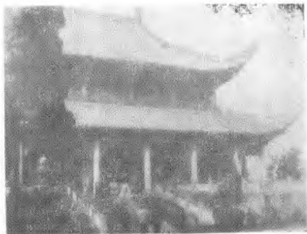
图为南岳大庙正殿。曾是游干班学员学习和生活过的地方。
